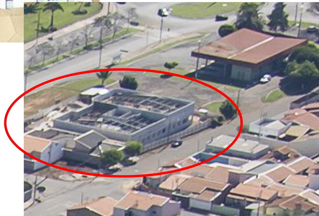
Câmara em construção
