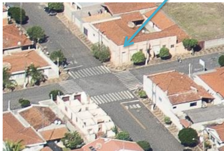
Ruas Cons. Rodrigues Alves / João Pessoa
