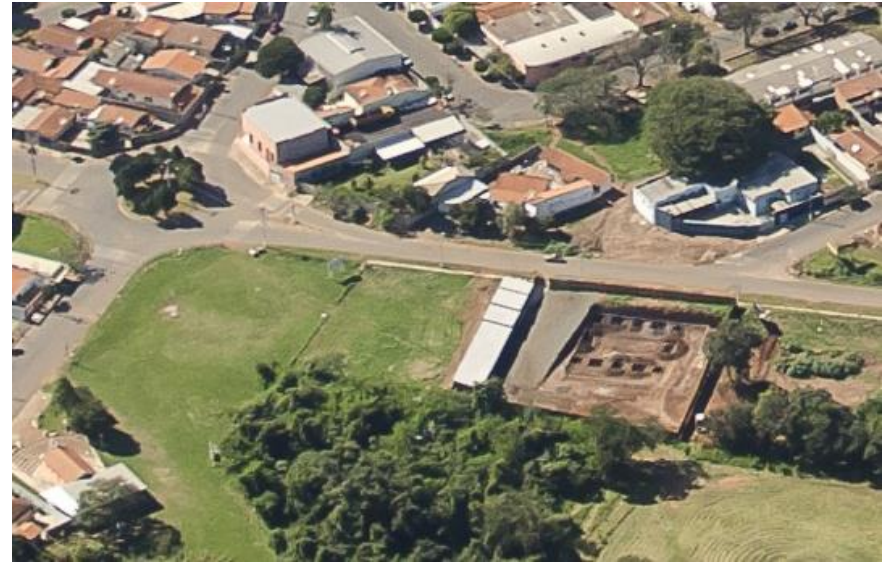
Novo Edifício Av. Manoel Gonçalves Neto
