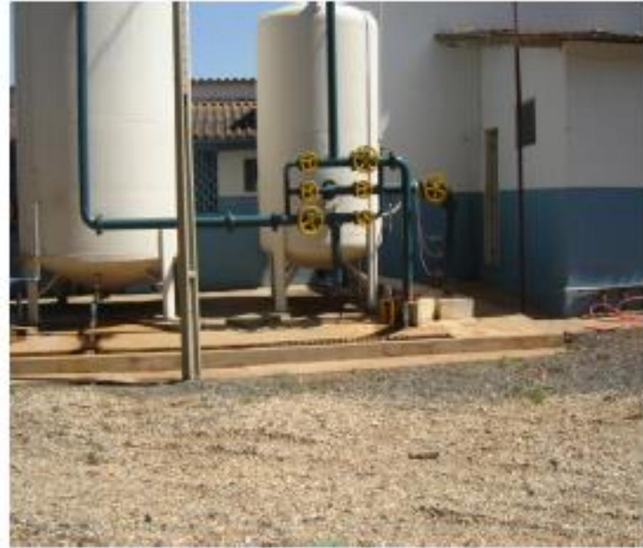
**Foto: 15** – ETA Compacta – Capacidade: 50m<sup>3</sup>/h
