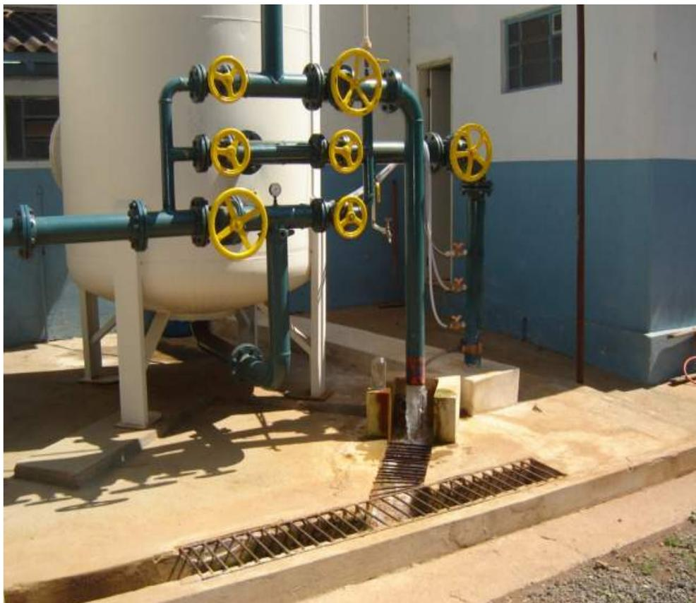
**Foto: 16** – ETA Compacta – Capacidade: 50m<sup>3</sup>/h
