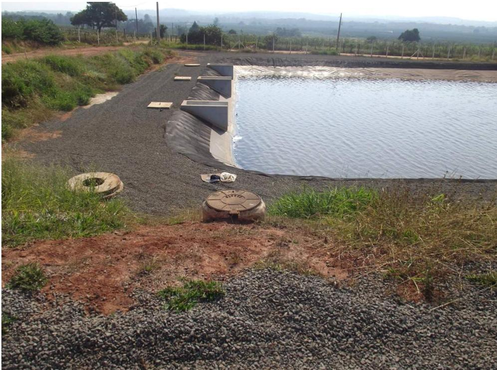
**Foto: 44** – 1ª Lagoa de Tratamento da Nova Estação de Tratamento de Esgoto - ETE
