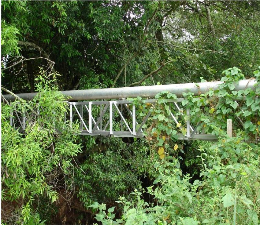
**Foto: 28** – Travessia de Rede de Esgoto
