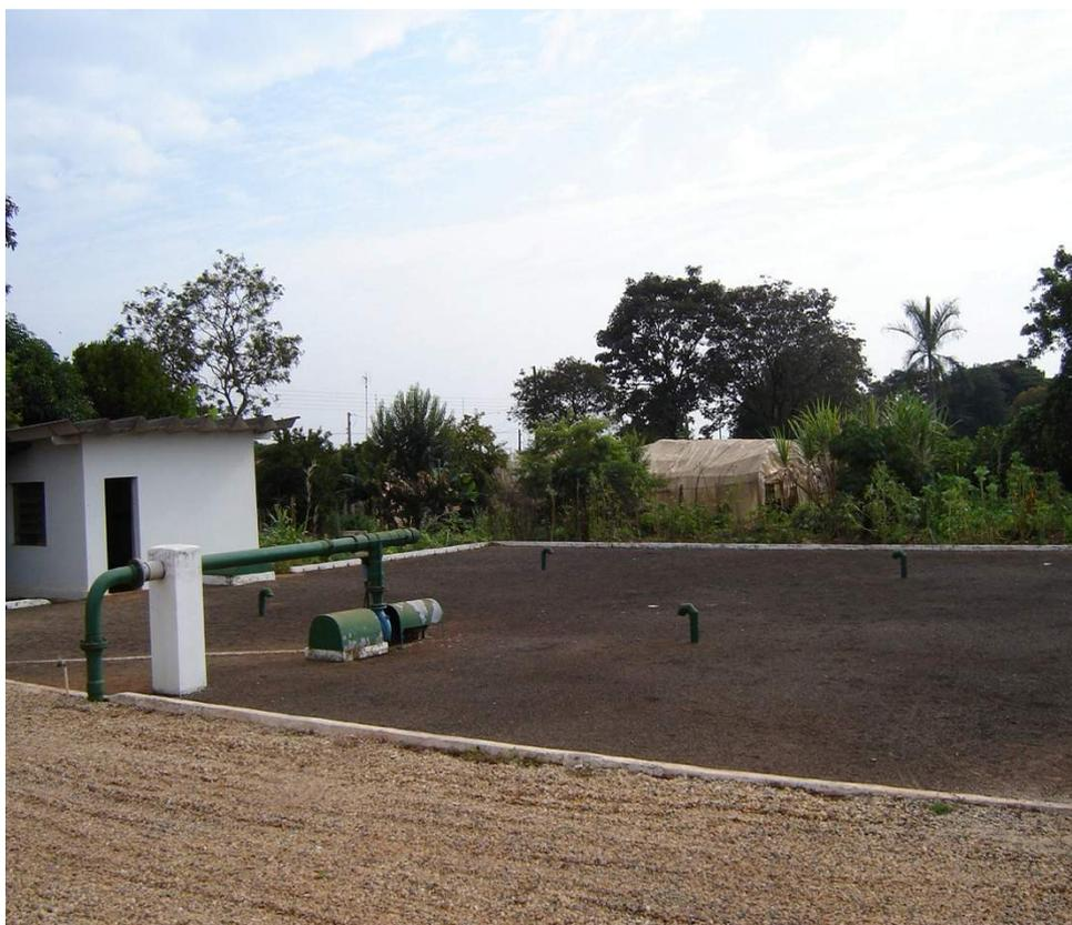
**Foto: 09** – Reservatório de Concreto Enterrado – Capacidade 1.000m<sup>3</sup>
