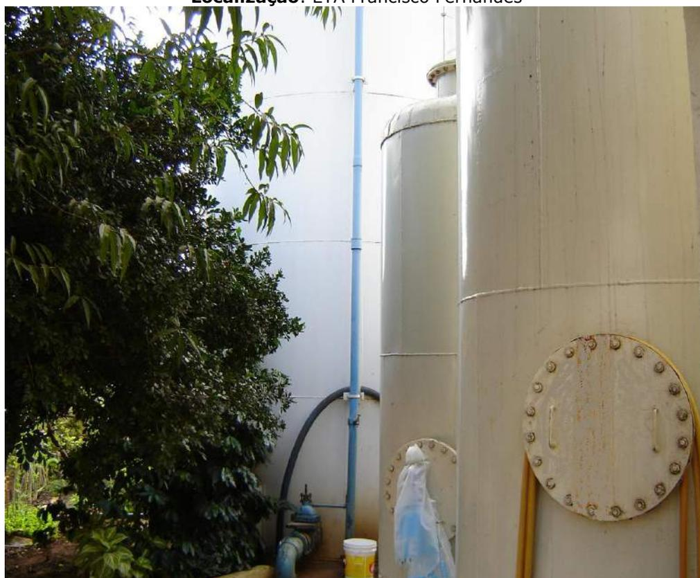
**Foto: 24** – ETA Compacta Hugo E. Muller – Capacidade: 20m<sup>3</sup>/h
