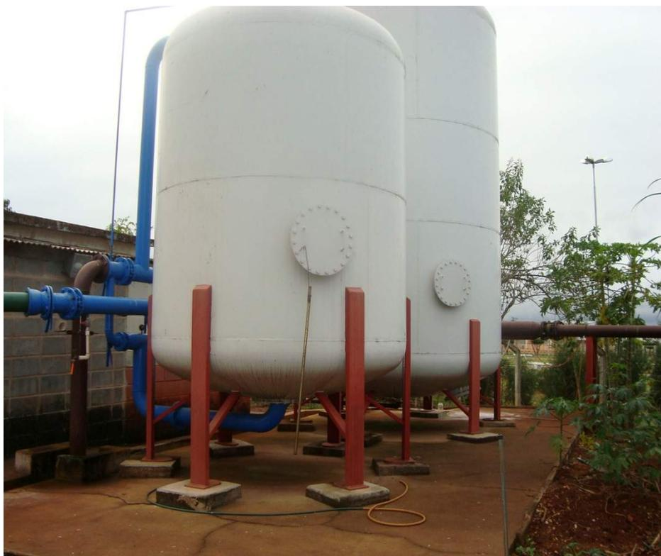
**Foto: 21** – ETA Compacta – Capacidade: 100m<sup>3</sup>/h
