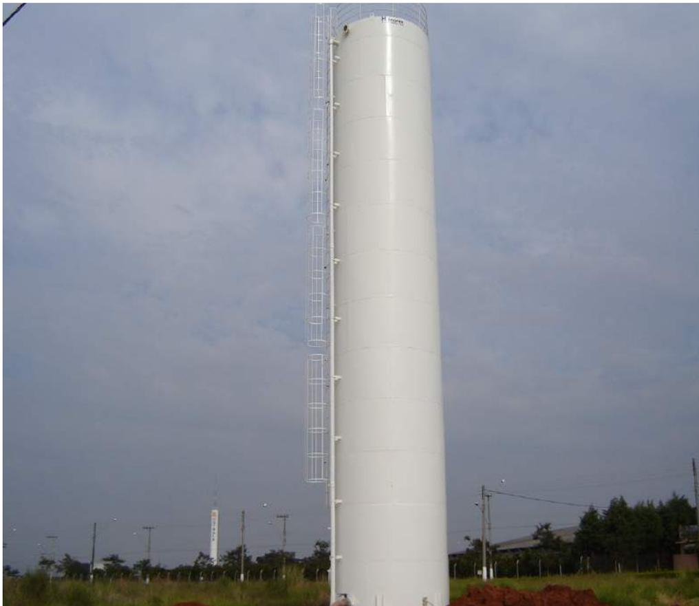
**Foto: 11** – Reservatório de Apoio – Capacidade: 100m<sup>3</sup>
