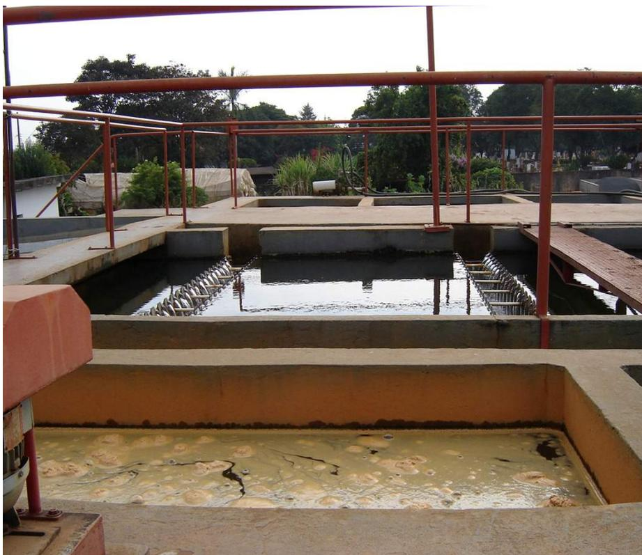
**Foto: 07** – Floculador / Decantador e Filtros – ETA Prefeito Egydio Corte
