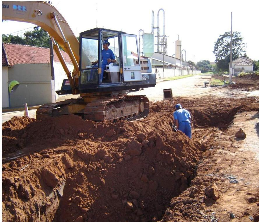
**Foto: 29** – Execução de Interceptor (Rede de Esgoto)
