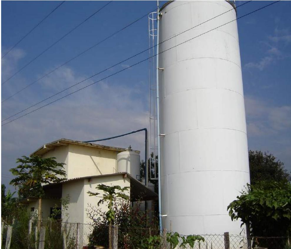
**Foto: 25** – Reservatório Apoiado – Capacidade: 120m<sup>3</sup>
